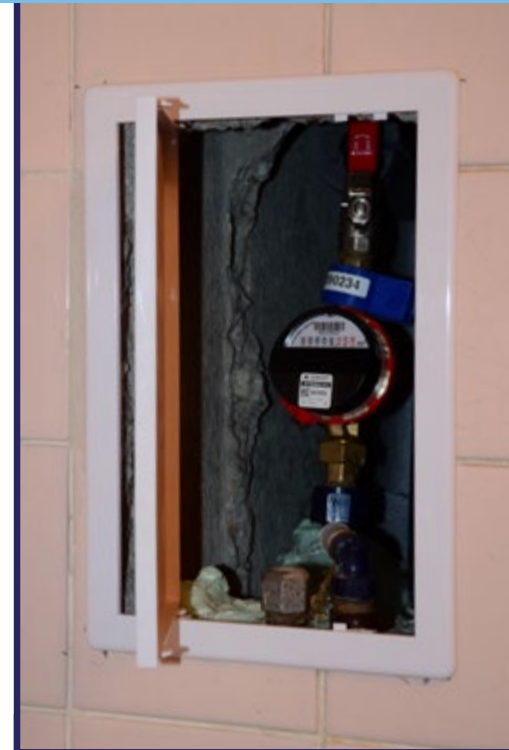
Po junkersie nie ma śladu, a w ścianie pozostały estetyczne drzwiczki, za którymi umieszczony został wodomierz
